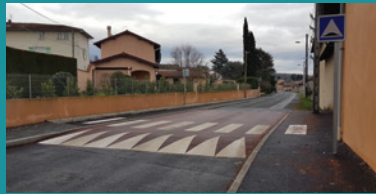
Sécurisation de la route de Trévoux
